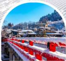
สะพานนากะบาชิ
